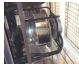
Секция вентилятора с ЕС-двигателем
